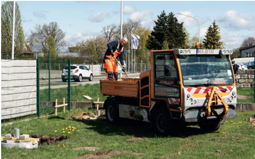
René Krülle vom städtischen Bauhof bei den Erdarbeiten für den neuen Bolzplatz in der Aumühle. Foto Wohlgemuth
