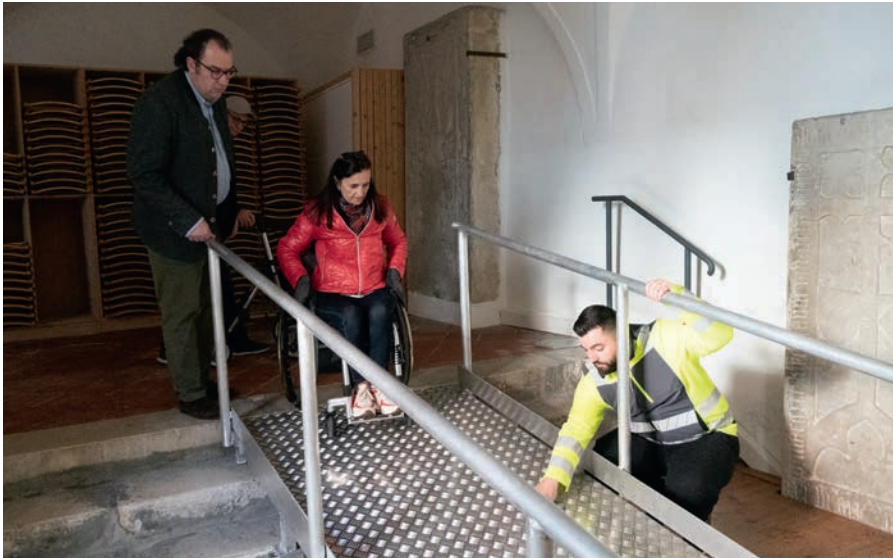
Stadtbaumeister Blerim Syla zeigt eine der neuen Rampen im Kreuzgang.
