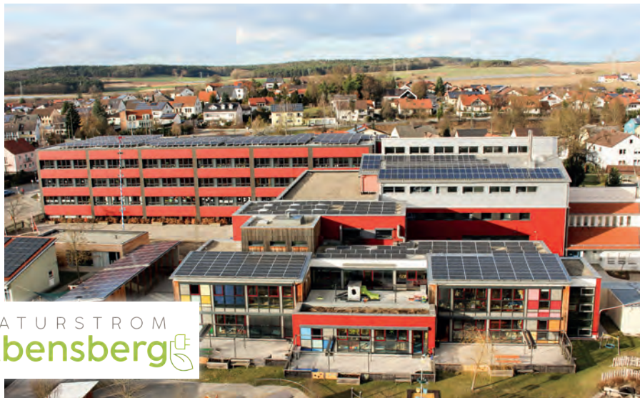
PV-Anlage auf Wichtelstube und Mittelschule.
