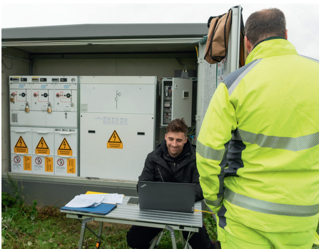
Der komplexe Schaltschrank verteilt, misst und speist den Strom ins öffentliche Netz ein.
