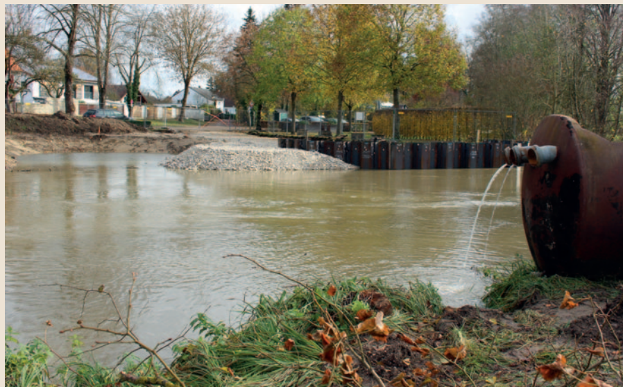
Die Bauarbeiten an der Abens haben begonnen.
