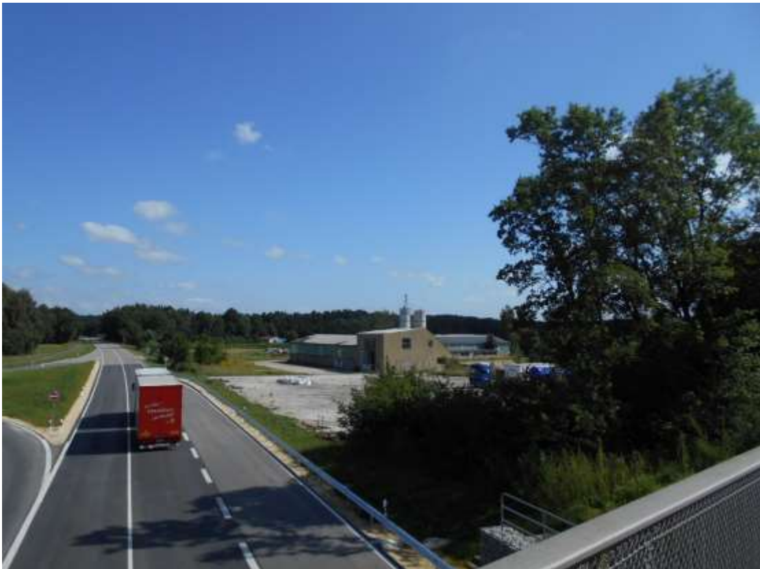
Fl. Nr. 2837 derzeitiger Zustand des Gebiets (Ausschnitt) – Blick von Südwesten nach Nordosten
