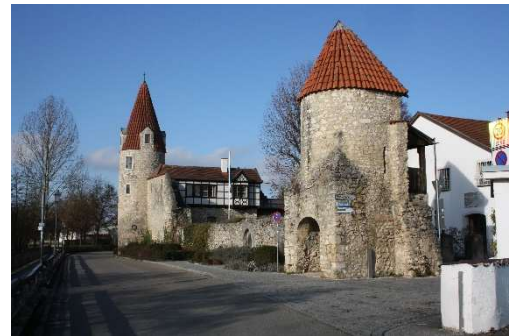
Blick entlang der „Abensstraße“
